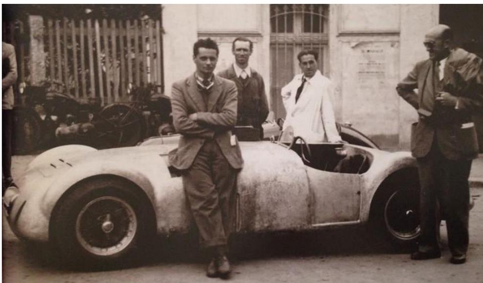
Nous avons vu en introduction que toutes les Maserati A6 vérifiaient deux conditions : avoir 6 cylindres en ligne atmosphériques et un châssis tubulaire. Cette 6 CS ne peut donc être considérée comme la première A6 car elle avait un châssis conventionnel à longerons d'acier plein.
