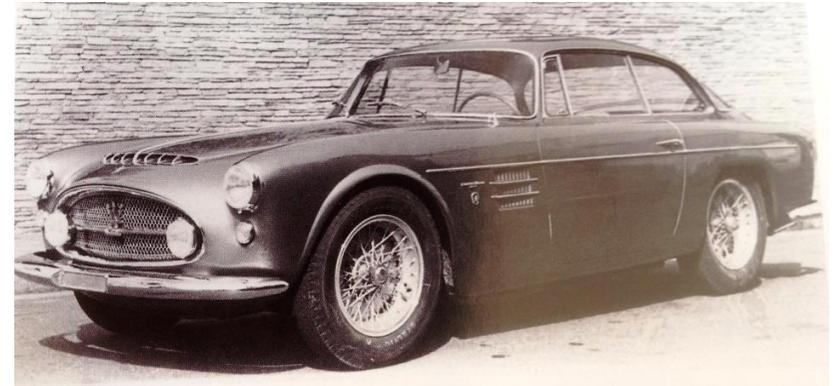
*2111 ci-dessus avec sa calandre très large et la prise d'air sur le capot. Tous les modèles suivant, tel celui ci-dessous, eurent une calandre plus fine et des extracteurs d'air derrière la roue avant englobant la baguette chromée latérale.*
