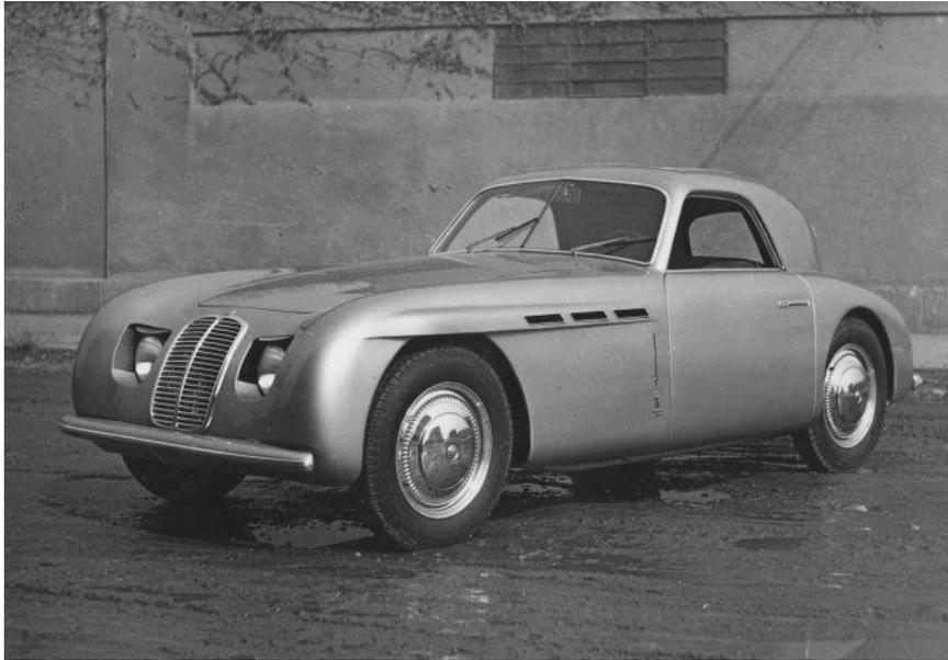
Cette carrosserie toute en aluminium était très fine et avant-gardiste pour l'époque avec ses phares carénés à commande mécanique (levier sous le tableau de bord actionnant un câble). Mais ce dispositif ne sera pas retenu sur l'A6 1500 GT définitive de (petite) série. Noter la finesse des lames de pare-choc, la calandre évoquant celle de la 4 CLT, les jantes pleines et la modernité globale, dans l'immédiat après guerre, de ce beau 3/4 avant .
